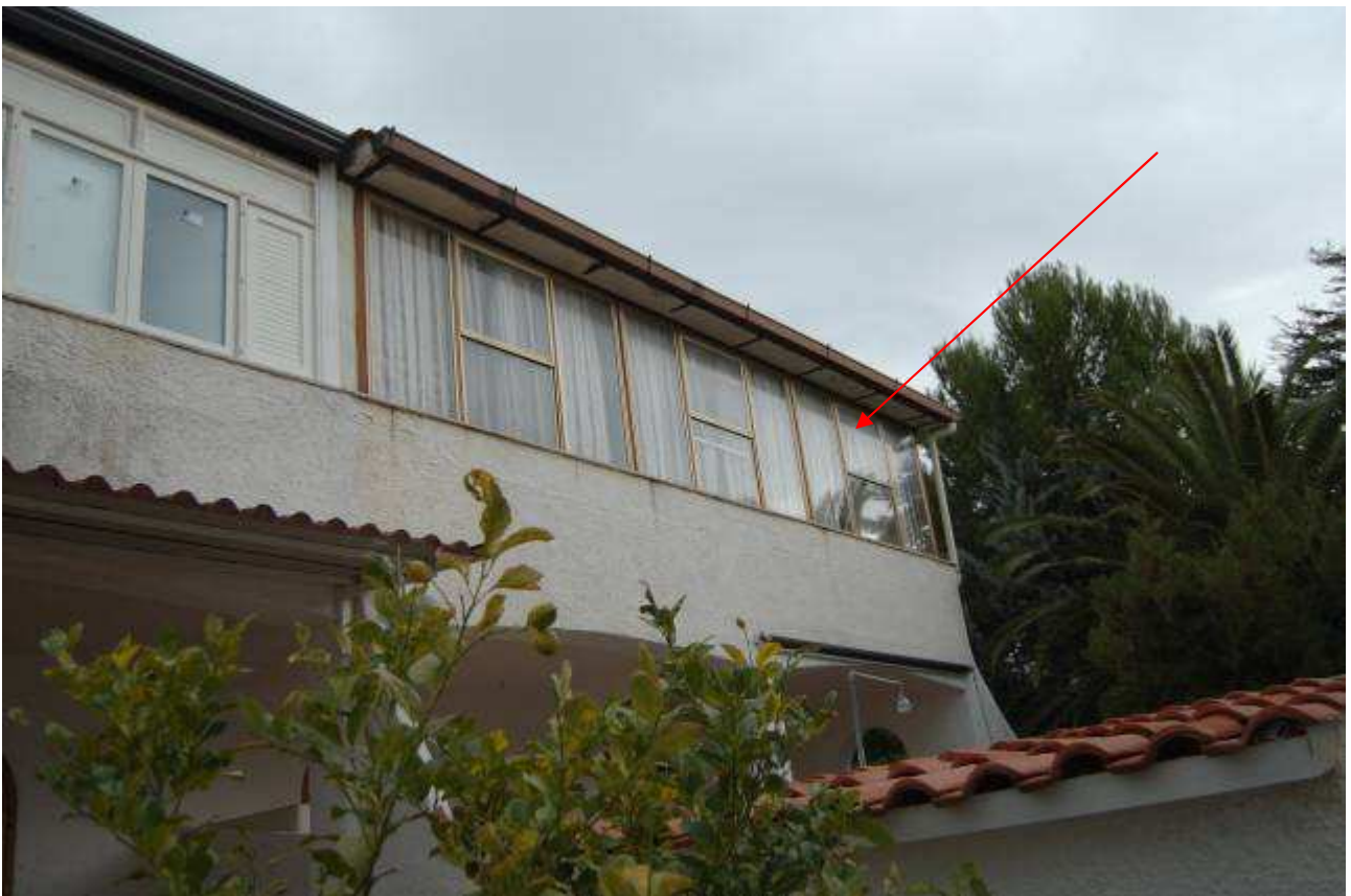
Chiusura a vetri della veranda sul lato sud (non autorizzata)
